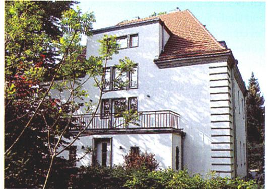
**Abb. B.5.2:** Der aus dem Dach tretende Treppenraum dieses Mehrfamilienhauses aus den 20er-Jahren wurde, nach außen hin unverändert, zu einem Zimmer der Dachgeschosswohnung umgebaut (Abb. B.5.3). (Arch.: Luka Kalkof, Leipzig)
